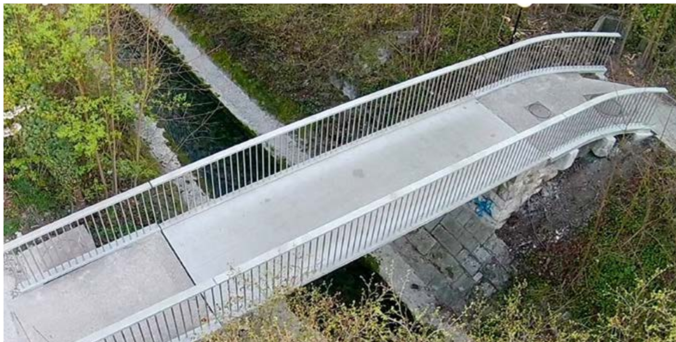
Betonbrücke gebaut aus CPC-Betonplatten: Die wohl leichteste Brücke der Welt.
