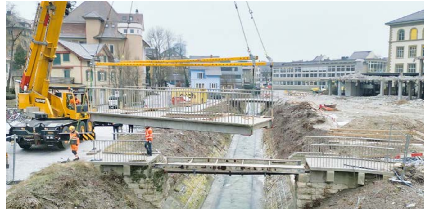
Re-Use: Die Velobrücke wird für eine neue Nutzung in Bülach abtransportiert.
